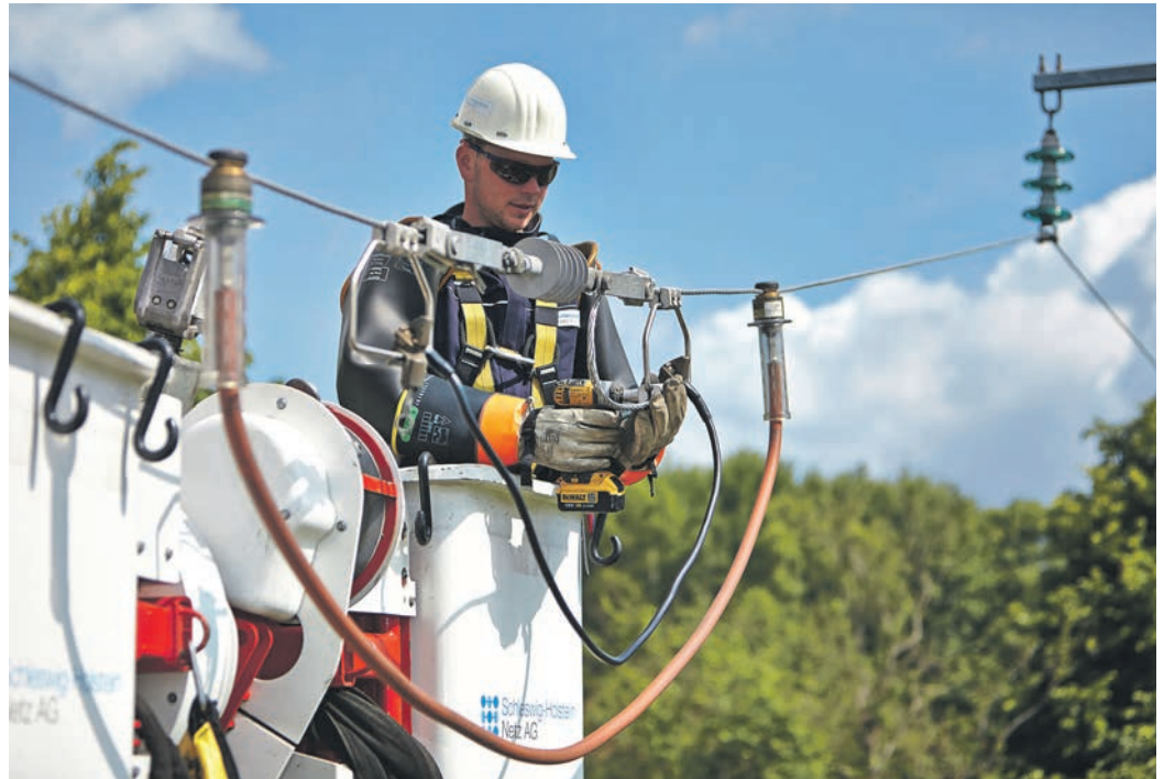
Ein Monteur von Schleswig-Holstein Netz „arbeitet unter Spannung“ – das heißt er nimmt Reparaturarbeiten an den Stromleitungen vor, während der Strom fließt.
