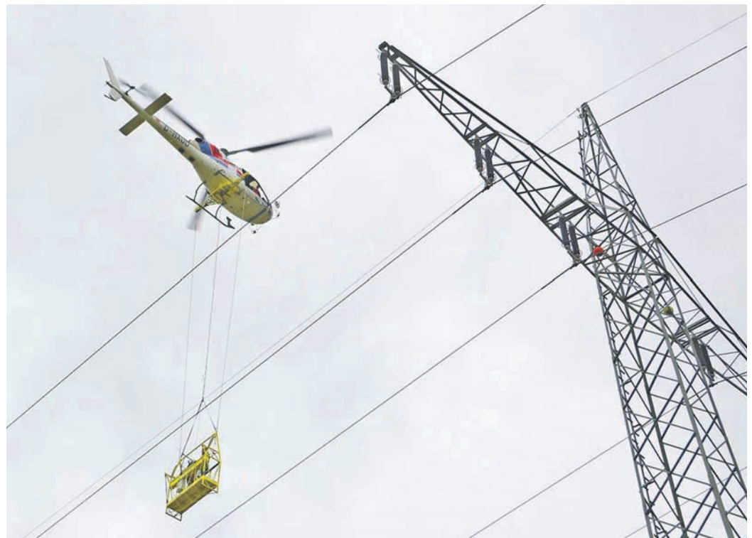
Das Anbringen von Vogelschutzmarkern per Hubschrauber an Hochspannungsleitungen
